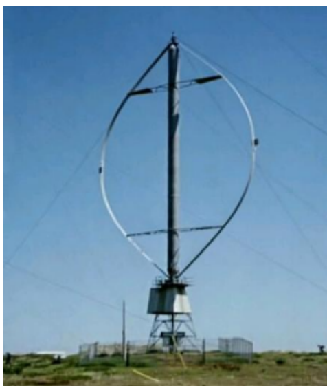
Figura 7 – Turbina de Darrieus de duas lâminas
